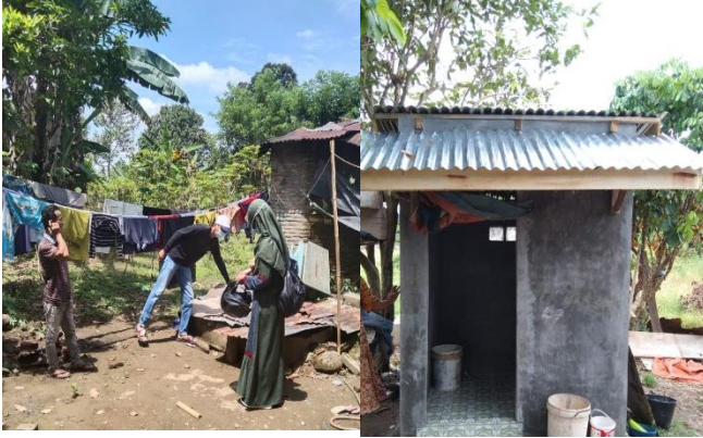
Gambar 4. Proses Pembangunan Sanitasi
