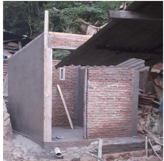
Gambar 3. Proses Pembangunan Sanitasi
